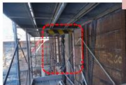
④枠組足場に保護、視認性向上のためのトラカバ設置+手掛部に養生テープ貼り
